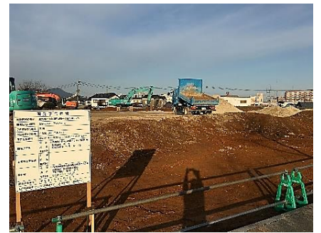
↑2月24日、「開発予告標識」のまま造成工事が施工されていた。この数日後、「開発許可標識」に建て替わっていたのはなぜでしょうか。
