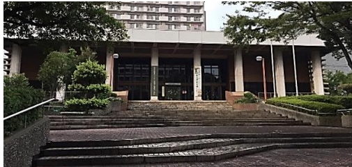
【埋蔵文化財センター】 小倉北区 1983年に九州初の考古学専門館として、1階(発掘調査を行う埋文調査室)、2階(考古博物館)、3階(収蔵庫)からなる複合施設として開館。2002年考古博物館は「いのちのたび博物館」(八幡東区)に移転し、発掘調査部門と展示室(戦時資料展示コーナー併設)になった。
