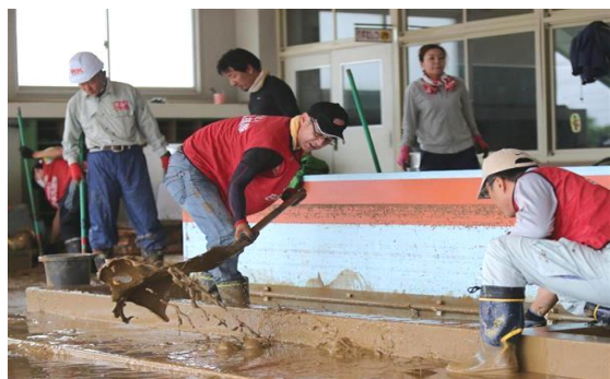
被害者宅で、土砂を取り除く作業に頑張るボランティア
