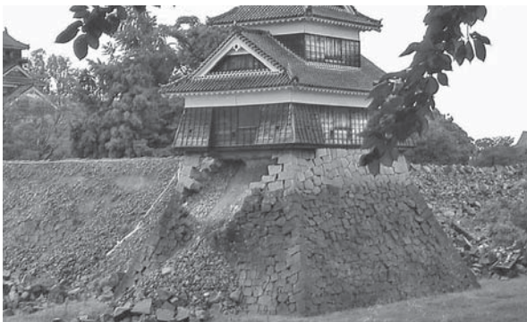
土台の石垣が崩れ落ちている熊本城
