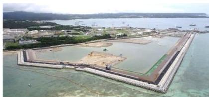
【チョイスさんの沖縄日記から転載】 沖縄ドローンプロジェクトから、辺野古の外周護岸で進んでいる嵩上げ工事のドローン写真(7月3日撮影)が送られてきた。工事用ゲートからは連日、多くのコンクリートミキサー車が入っているが、ポンプを使ってL型擁壁の底板部分のコンクリート打設が急ピッチで続いている。1カ所の施工単位は10m。K1~K4護岸は総延長1,674mあるから、このようなブロックが168カ所ほど造成されることとなる。現時点でまだ7カ所ほど造成されているにすぎない。この嵩上げ工事だけでもかなりの期間がかかる。
