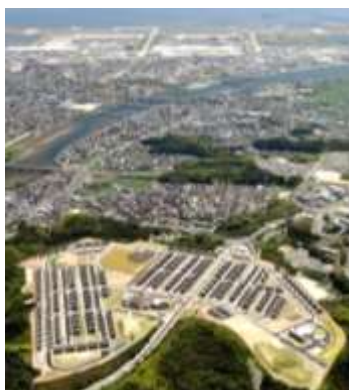
上方は米海兵隊岩国基地。手前は愛宕山地区に完成した米軍住宅。一戸あたりの建設費は七、八千万円という。写真は中国新聞より
