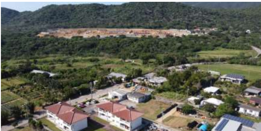
石垣駐屯地（仮称）建設予定地の前には、開南集落がある。石垣ドローンチーム撮影。
