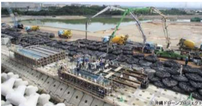
沖縄ドローンプロジェクトの写真。撮影は今年の夏頃に、護岸のかさ上げ工事が行われている写真。滑走路の高さは、最終的に10mになる。
