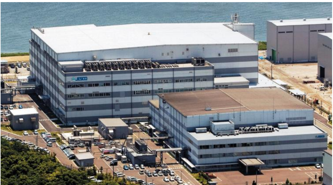
PCB処理施設の全景(パンフレットから)。手前の第 1 期処理場は、解体工事に向け操業は行われていない。後ろの第 2 期処理場の新規受け付けは 12 月 28 日までで、来年 3 月末には操業を終える予定。
