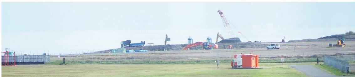
北九州空港の滑走路の延長工事の様子。2500mを3000mに延ばす工事は、昨年12月2日着工。供用開始は2027年8月31日の予定
